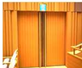
避難口誘導灯
