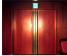
避難口誘導灯
